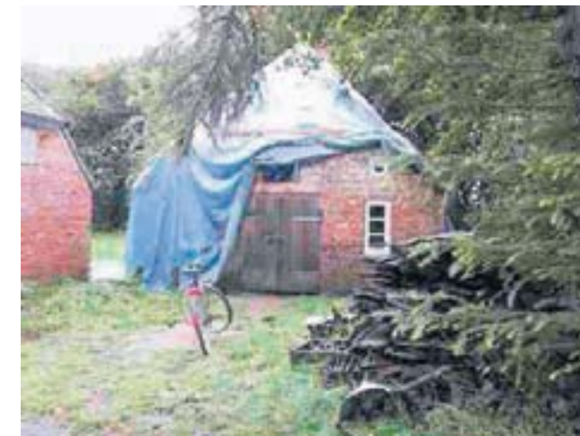
Sådan så Serup Smedje ud, inden foreningen gik i gang med en større og gennemgribende renovering. Foreningen har 40 medlemmer, men vil meget gerne have nogle flere, der er interesserede i at bevare de gamle håndværk. Privatfoto.
